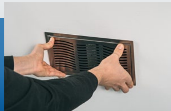
Premere la griglia in acciaio inox sul telaio, farla scattare e il gioco è fatto. Come sempre PLUGGIT!
