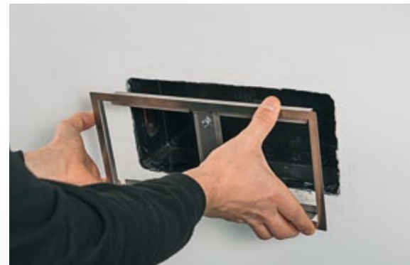
Il telaio a incasso si inserisce nel diffusore.
