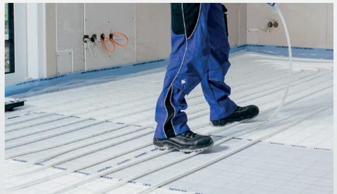
Die Zwischenräume werden mit Uponor Klettplatten aufgefüllt, das Fußbodenheizrohr wird schnell und einfach über die gesamte Raumfläche verlegt.
