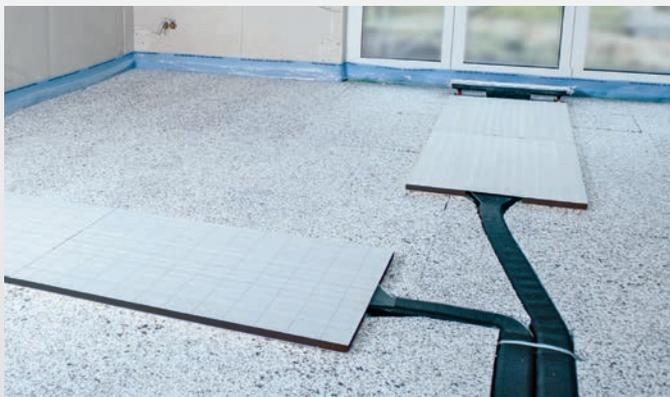
Uponor Comfort Air wird zusammen mit den Pluggit Pluggflex Lüftungskanälen verlegt. Entsprechende Verbinder ermöglichen den fachgerechten Anschluss an das Pluggit Lüftungssystem.
