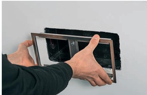
Le cadre de montage est inséré dans la sortie d'air.
