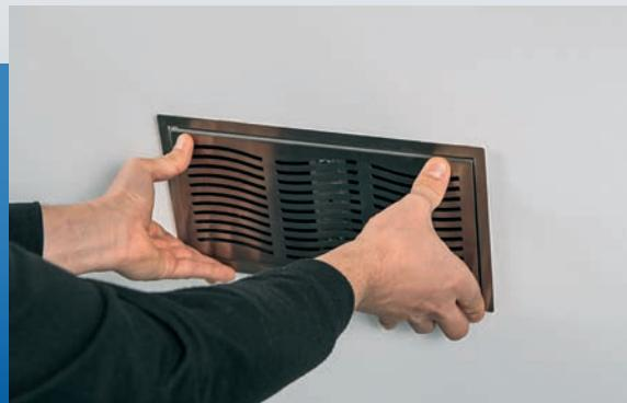
Poser et encliquer la grille de protection en acier inoxydable – c'est terminé. Typiquement PLUGGIT !
