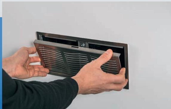
Pour l'insertion rapide et exacte de la grille de protection, des rails de guidage sont disponibles sur le cadre de montage.
